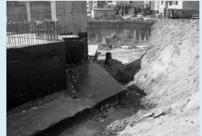
Фото 3. Нижняя плита коробчатого фундамента
