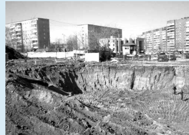
Фото 2. Котлован для коробчатого фундамента в элювиальном грунте
