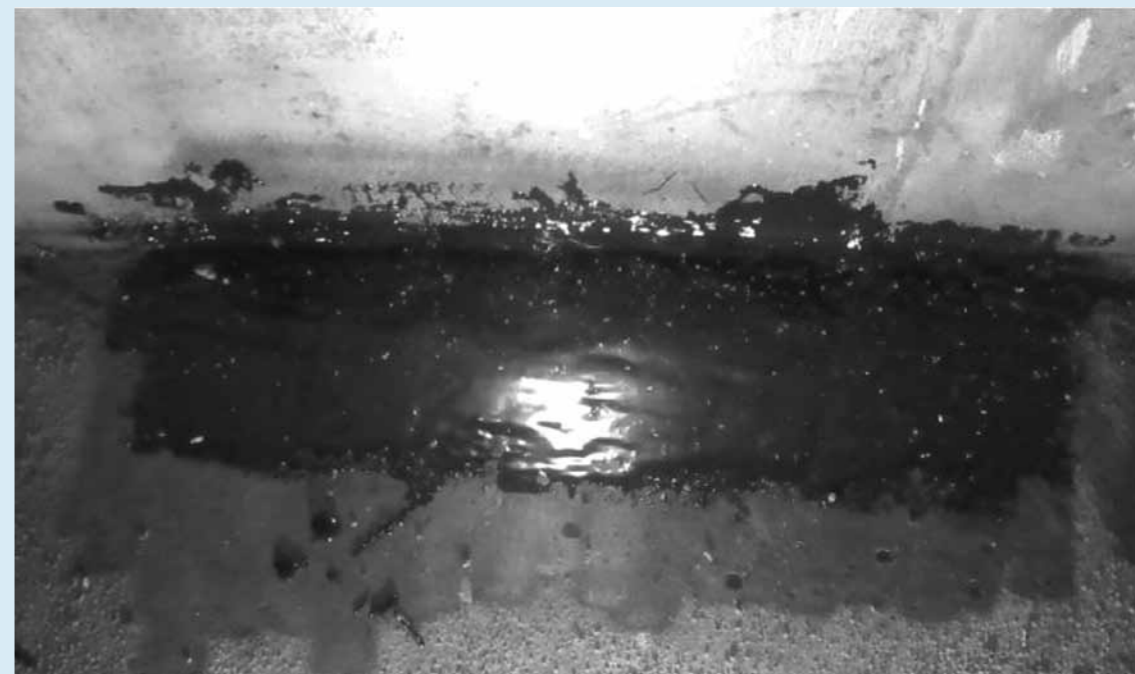
Рис. 1. Ремонт язвенной коррозии металлической конструкции полимерным материалом на основе эпоксидной смолы
