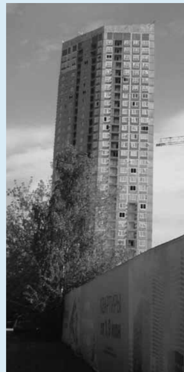
Фото 1. Дом в ЖК «Цветной бульвар» (г. Екатеринбург, застройщик – Группа ЛСР). Через год осадка дома не превысила 2 см при расчетной – 3 см
