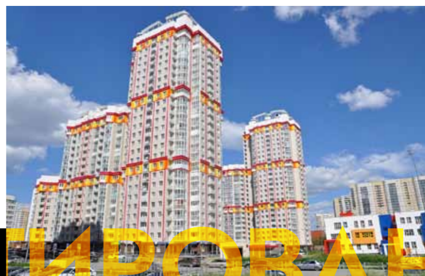
Жилой комплекс «Времена года»
